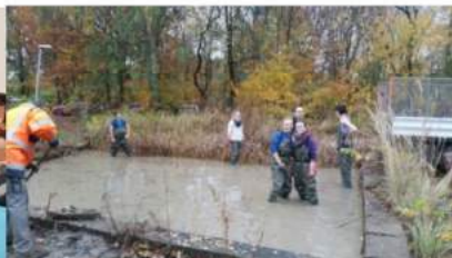
Restauration du bassin du SN1
