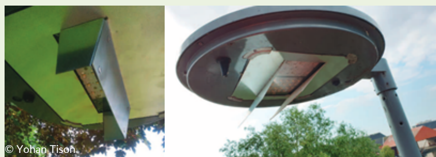
Lampadaires comportant plusieurs modules LED de températures de couleur différentes et munis de coupe-flux installés dans l'espace de la Citadelle.
